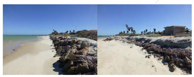
FIGURE 3-6 TYPICAL SECTION OF BEACH AND ROCK ARMOUR STRUCTURE (LEFT); GAP BETWEEN TWO STRUCTURES CAUSING LOCALLY INCREASED EROSION (RIGHT)
