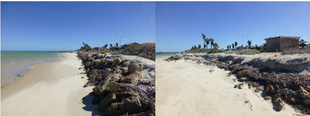
**FIGURE 3-6 TYPICAL SECTION OF BEACH AND ROCK ARMOUR STRUCTURE (LEFT); GAP BETWEEN TWO STRUCTURES CAUSING LOCALLY INCREASED EROSION (RIGHT)**
